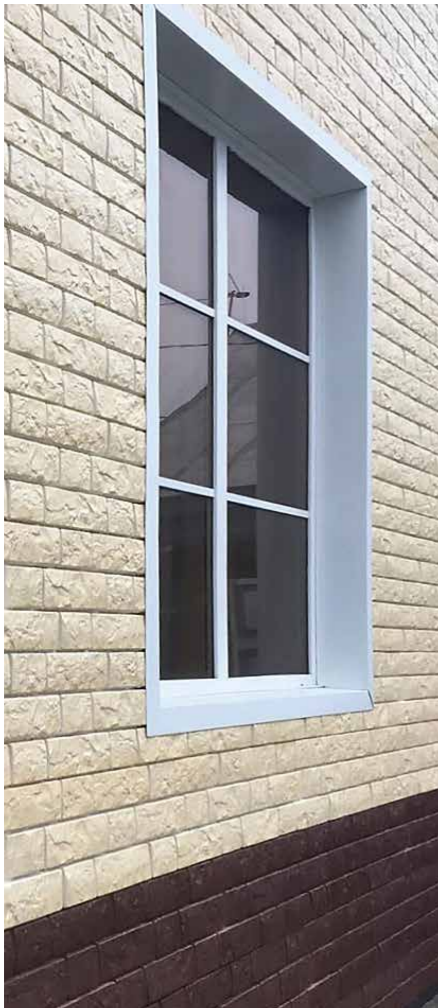
Пример монтажа сайдинга серии LUX под камень
